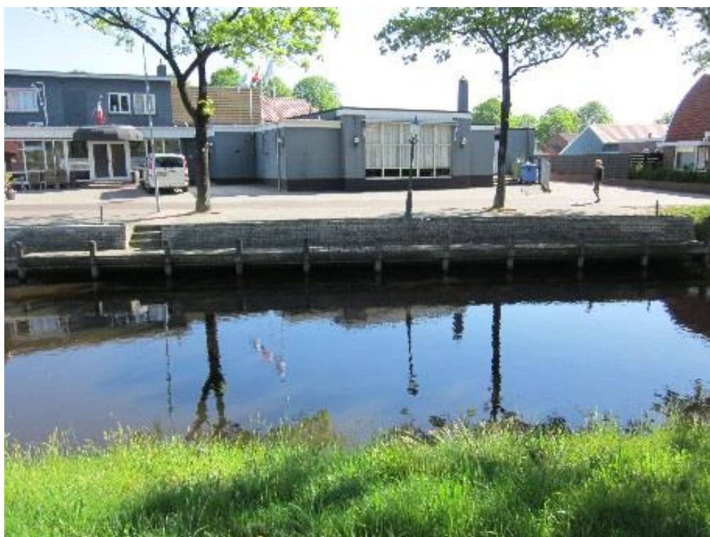
Afbeelding 1 Kademuur en (aanleg)steiger
